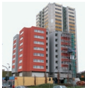
Mit KfW-Hilfe saniert: Block in der Mainzer Str. in Kaiserslautern
